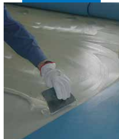
Applicazione di Ultrabond Eco V4 SP - Casa di Riposo San Martino - Italia
