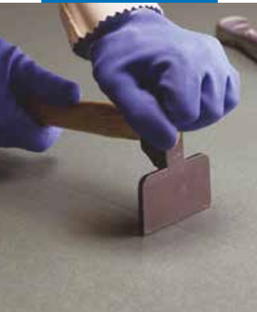
Massaggiatura dei teli sulla giunta
