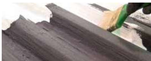
UNOLASTIC può essere sovraverniciato con la pittura riflettente WHITE REFLEX o con la pittura ELASTOLIQUID S
