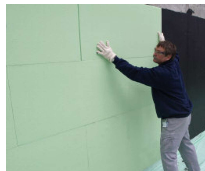
Applicazione dei pannelli isolanti Styrodur nel letto di posa contenente PCI Pecimor DK.
