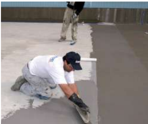
Impermeabilizzazione di una piscina con Mapelastic
