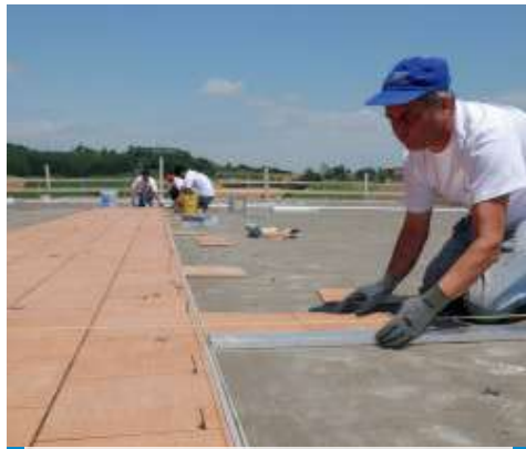
Posa di ceramica con Kerabond + Isolastic
