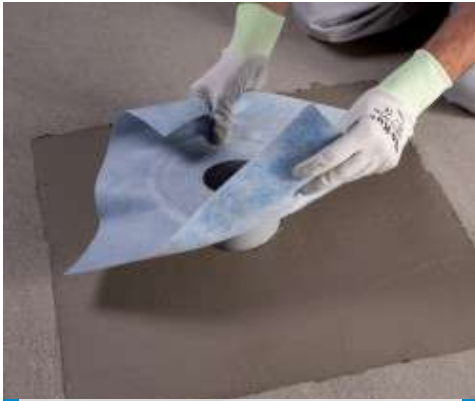
Posa di Drain Vertical, pozzetto di scarico, su Mapelastic
