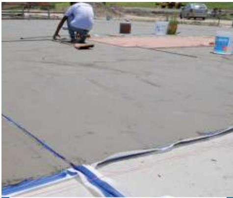
Impermeabilizzazione dei massetti con Mapelastic e Mapeband
