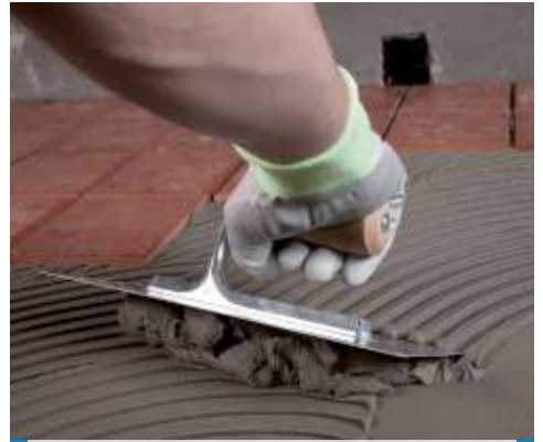
Posa di Granirapid su terrazza impermeabilizzata con Mapelastic
