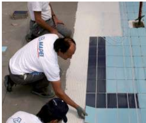
Posa di rivestimento ceramico su Mapelastic
