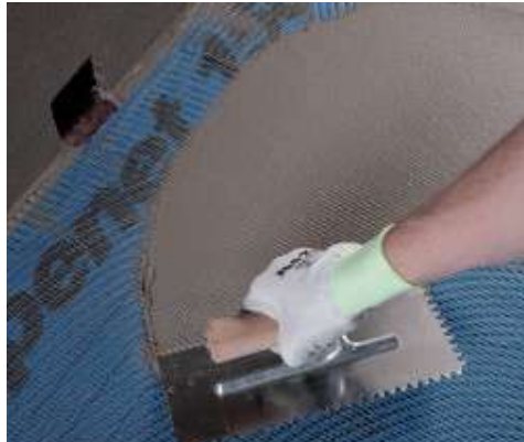
Stesura di Mapelastic su Mapenet 150
